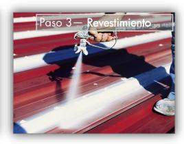
El EMSOL® RM-8400 es un acrílico de última generación modificado con esferas cerámicas e inhibidores de óxido de zinc para producir un producto que una vez fraguado se convierte en una membrana-barrera elastomérica que no se ve afectada por la intemperie (rayos UV), no se endurece con el tiempo, elimina la corrosión del metal y además refleja la radiación infrarroja de la luz solar lo que disminuye la carga termal del techo generando ahorros energéticos.
